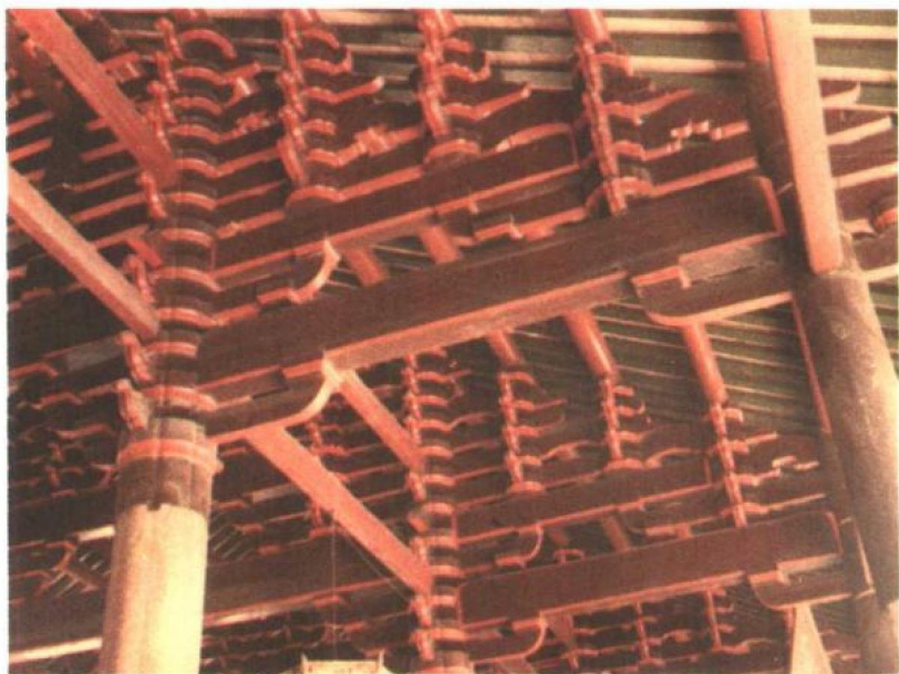
▲ 潮州开元寺天王殿梁架结构
