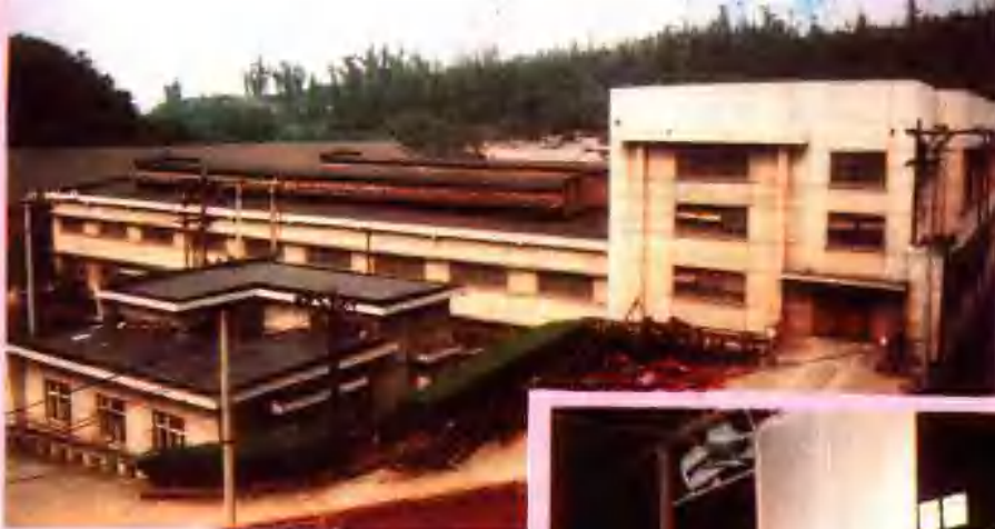
◁自贡中国电焊厂 生产车间外景
