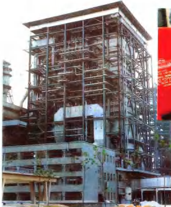
△东方锅炉厂生产的配 30 万千瓦机组亚临界自然循环汽包锅炉在山东邹县电厂投产
