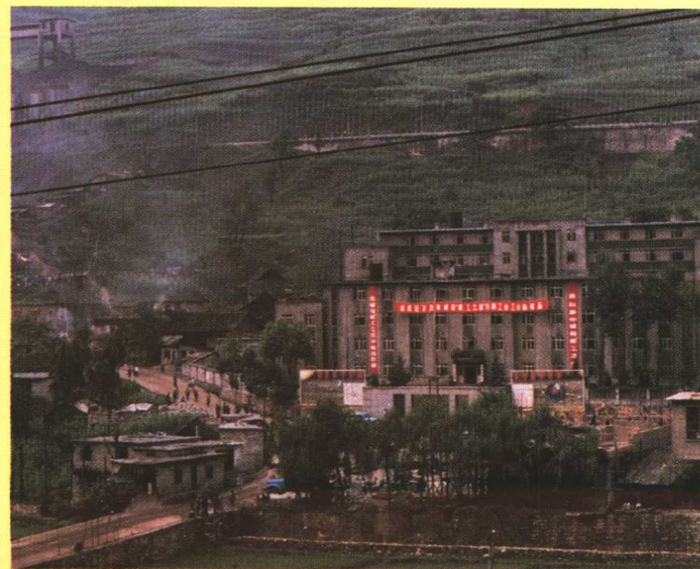
全省有设计能力 10 万吨以上的斜井 17 对，总能力 584 万吨。图为大河边斜井，能力 60 万吨。
