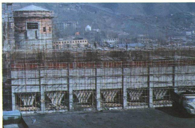
矿建施工在进行
