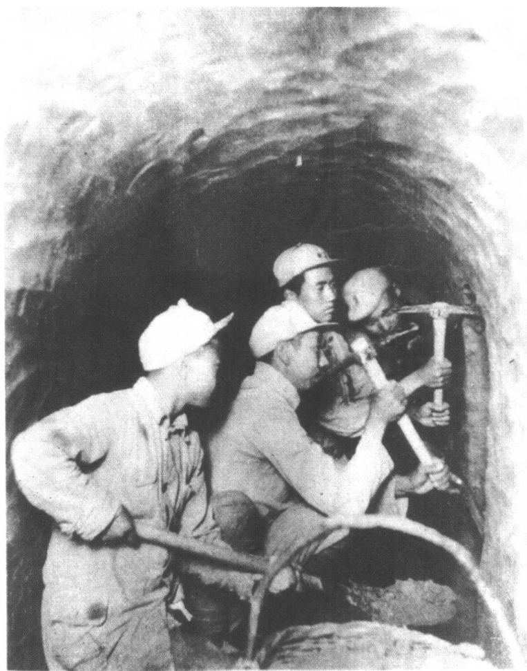
挖坑道、埋炸药。
