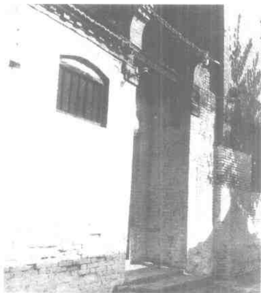
3 京汉铁路总工会郑州旧址
