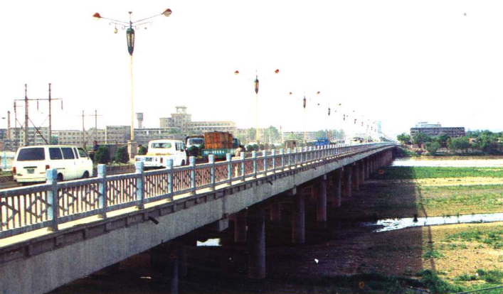
渭河公路大桥
