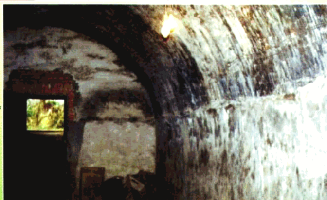
半地下式通风库内部结构
