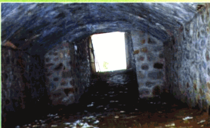
地下式土窖内部结构
