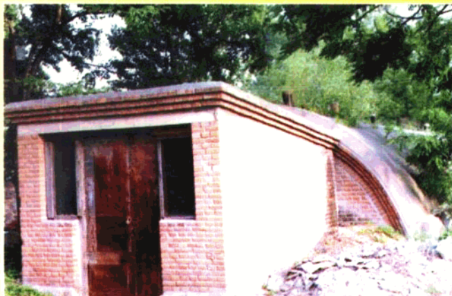
半地下式通风贮藏库
