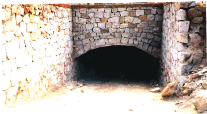
地下式通 风窖入口
