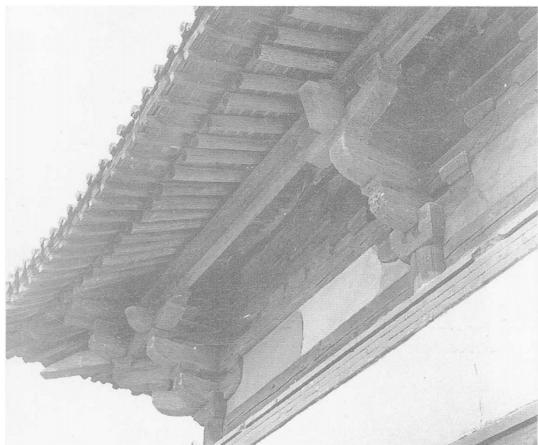
图1-4 河北正定县孔庙正殿斗拱
