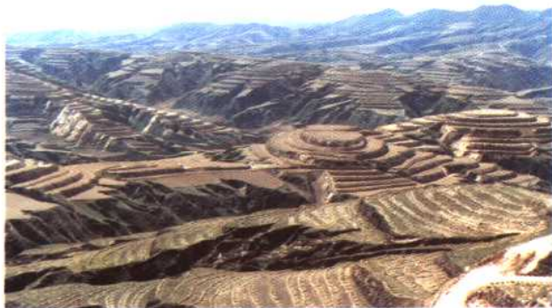
岚县曲井综合治理工程
