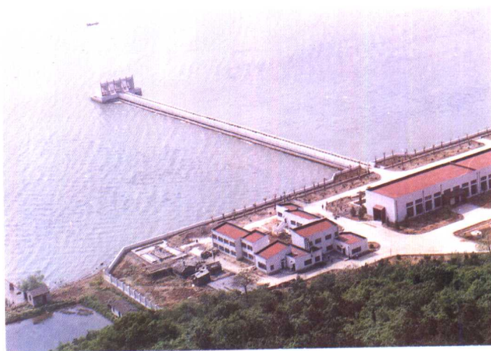
自来水厂取水口
