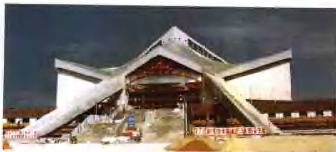
▲体育馆主体工程完工（何耘 摄）
