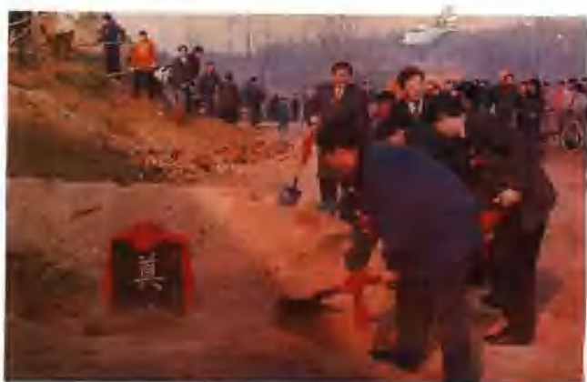
▲二南路改建工程开工（章海 供）
