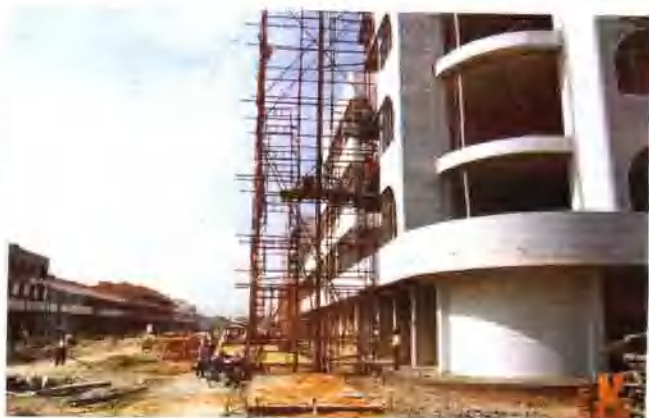
▲正在建设中的中所综合市场（何耘 摄）
