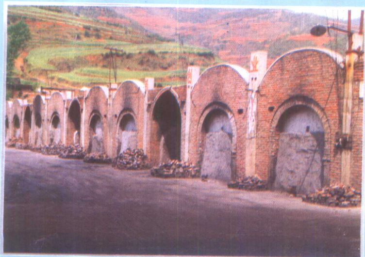
盘县特区火铺镇焦化厂引进的“75—1”型炼焦炉
