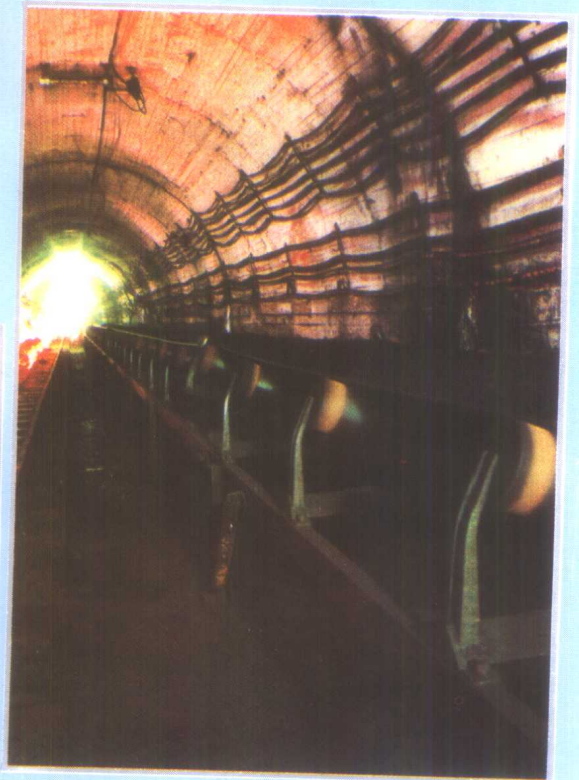
水城矿务局汪家寨矿斜井皮带运输线
