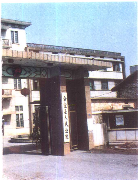
分宜县人民法院办公楼
