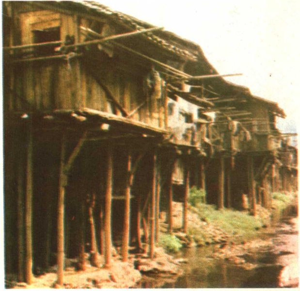
沱江江畔吊脚楼
