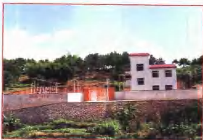
1998年12月建成的梅县畚江35千伏输变电站外景
