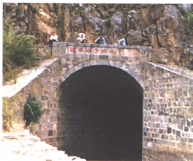
这年海子排洪隧道
