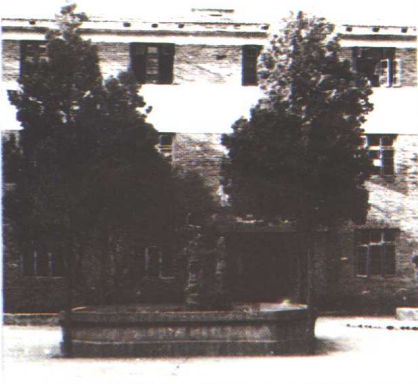
贞丰县人民医院住院部一角
