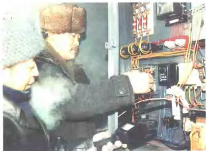
维修水电设备
