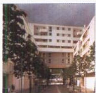
G · 莫里奥建筑设计事务所 ZAC 博西住宅 Atelier Georges Maurios ZAC Housing in Bercy
