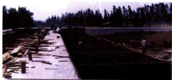
施工中的蛇场一角
