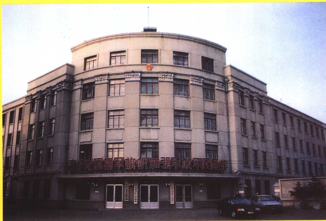
动力区委、区政府办公楼
