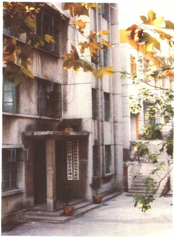
黔南州气象局办公楼
