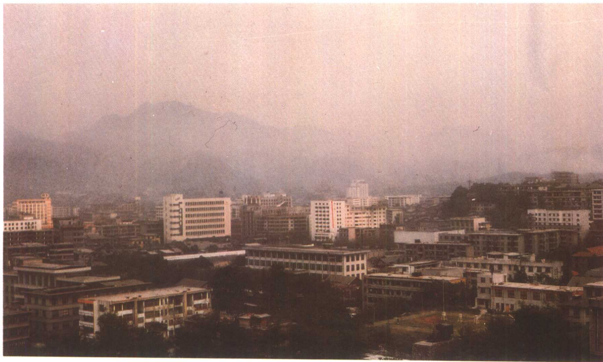
黔南自治州气象局在州府——都匀市区一隅
