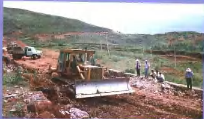
● 牟元公路杨水段路基改造 施工现场
