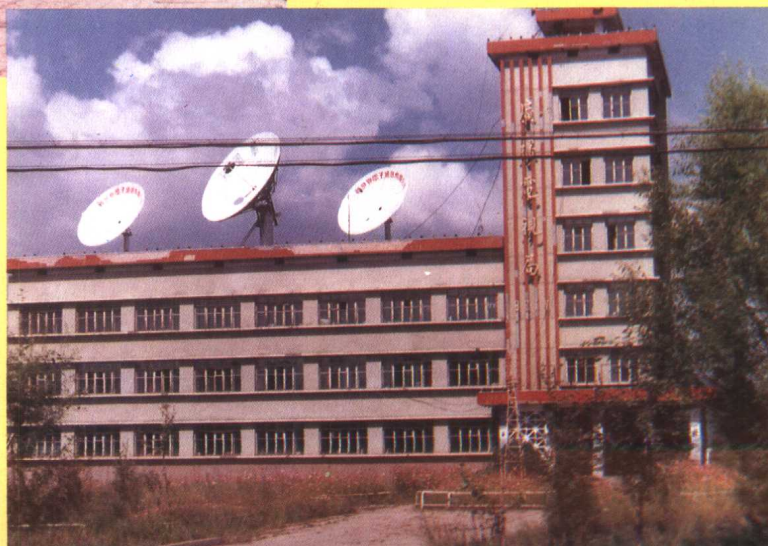
呼中区广播电视局大楼
