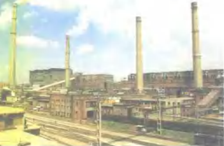
1958年投产、1989年扩建的吉林热电厂 (装机总容量85万千瓦)
