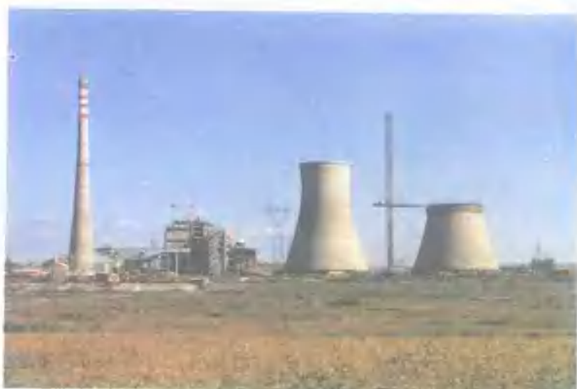
1988年施工中的珲春发电厂
