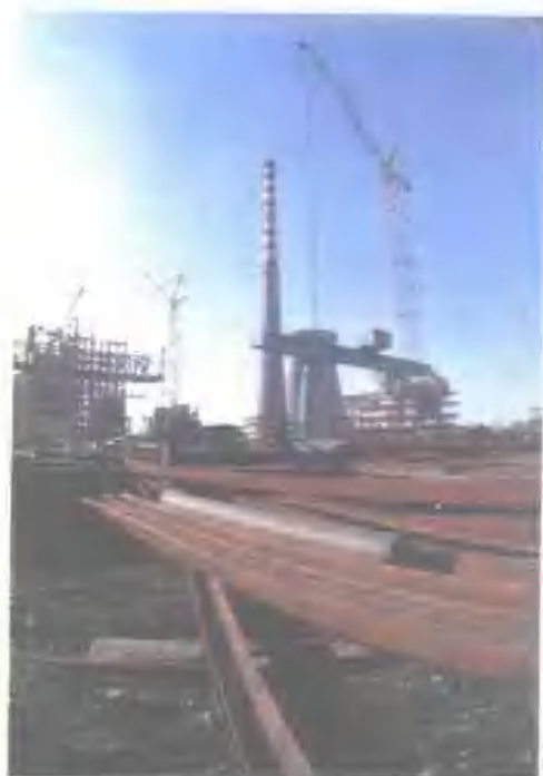
1989年长春第二热电厂在建设中
