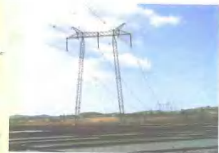
1990年500千伏东长哈送电线路 在建设中
