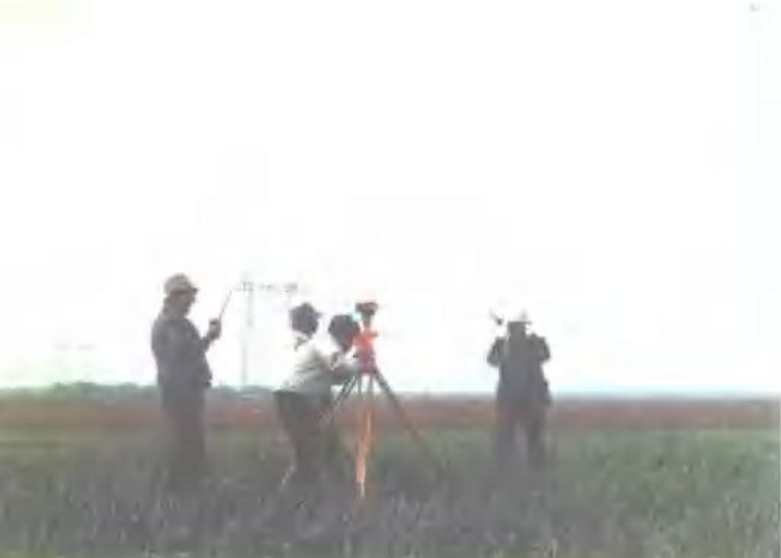
1984年省电力设计院勘测队在现场进行 实地测量
