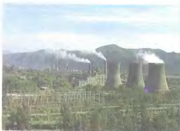
1963年扩建的二道江发电厂(总容量8.6万千瓦)
