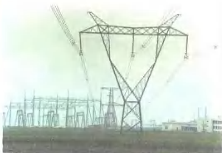
1990年500千伏长春合心一次变电所在建 设中
