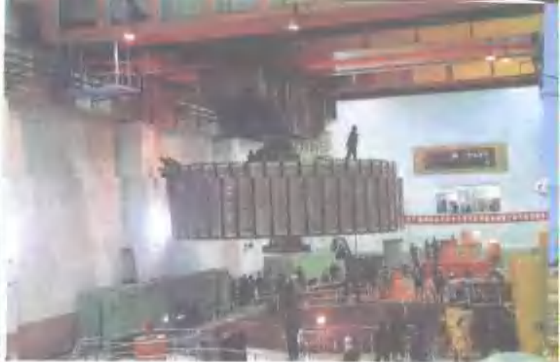
白山发电厂30万千瓦水轮机吊转子大修
