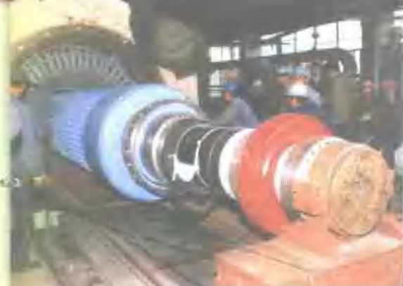
1987年长山热电厂20万千瓦机转子安装
