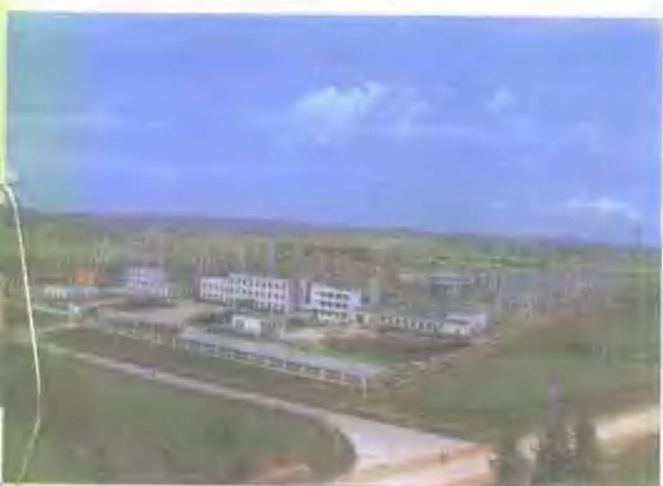
1986年建成的500千伏东丰一次变电所
