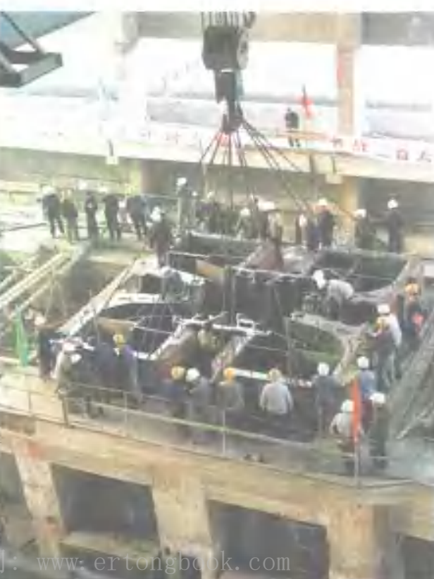
1984年火电 公司职工在通过 发电厂进行锅炉 大件起吊(左)
