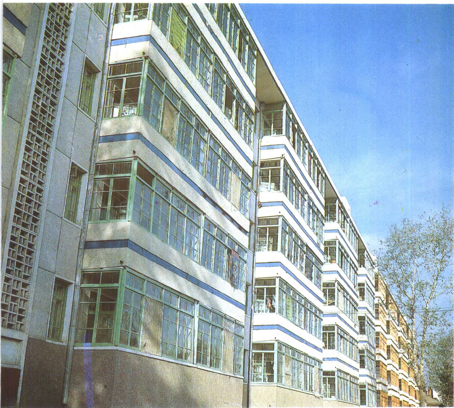
新建的居民住宅
