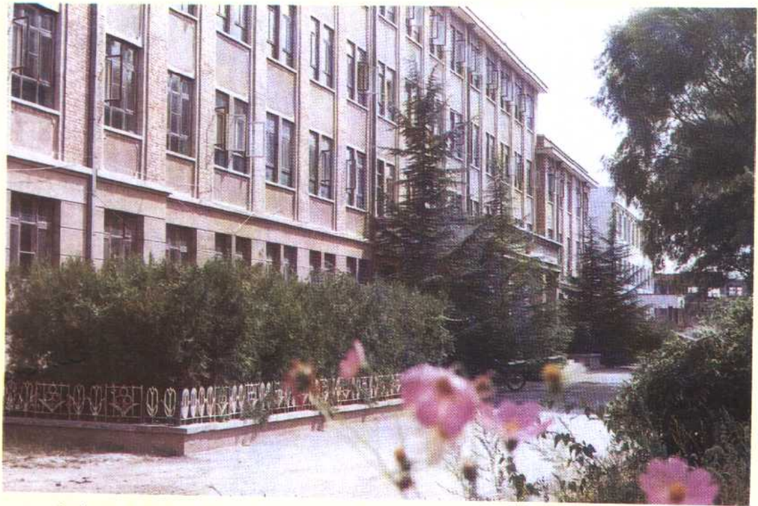
县委、县政府办公楼
