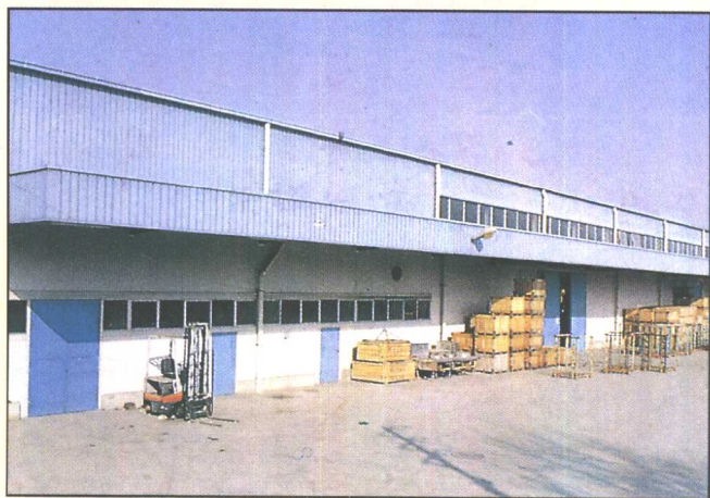
全国首座气调库——北京朝阳气调库外景
