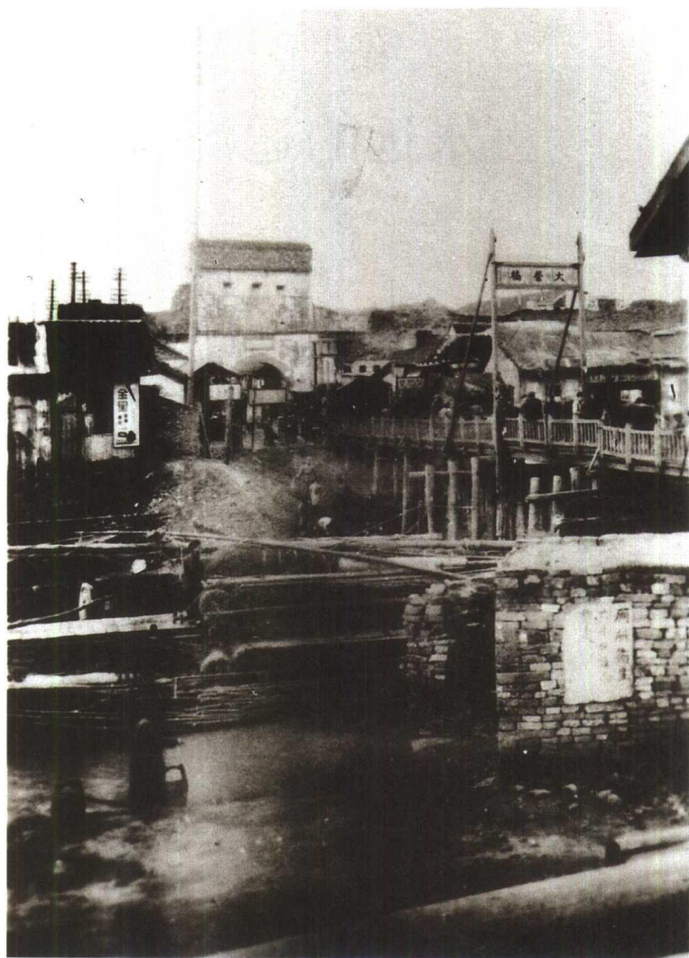
近代筑成的大荣桥，横跨在运河上，给人们带来方便：这是一座钢索起吊桥，用人力起吊，让船只通过。
