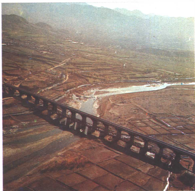
引崗灌渠大渡槽
