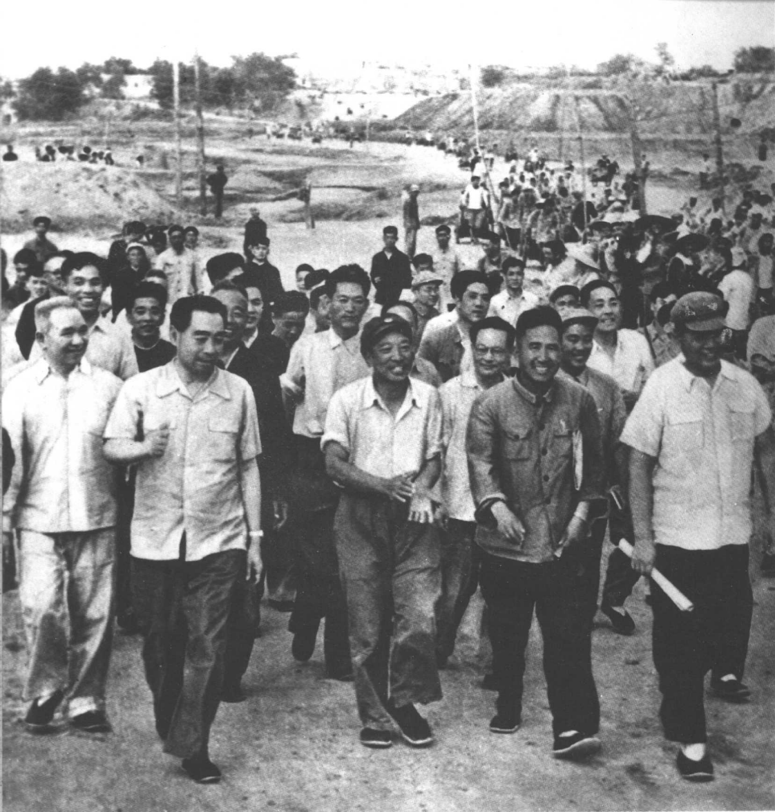
1959年，國務院總理周恩來視察崗南水庫修築工地。
