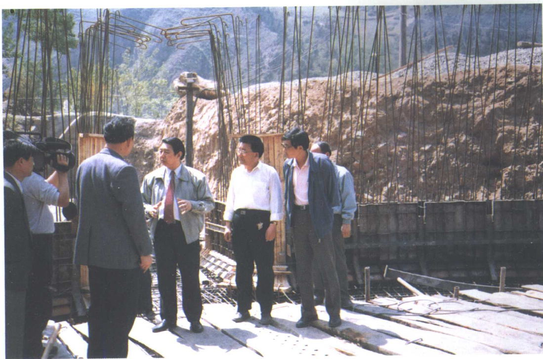
西安市市长冯煦 初视察黑河引水 工程工地(1996 年摄)
