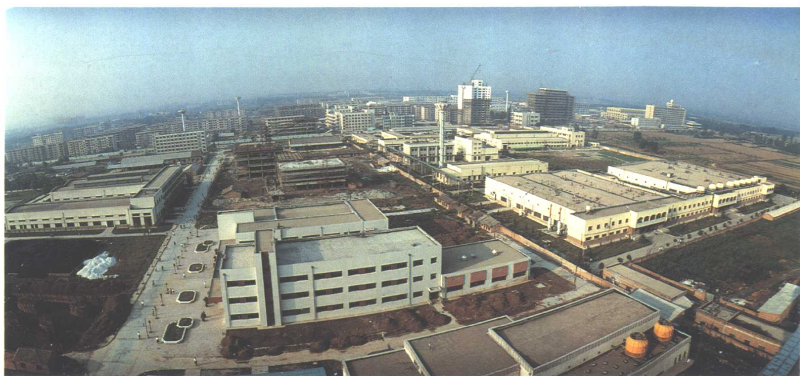
建设中的西安经济 技术开发区(1996 年摄)
