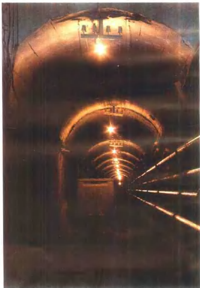
新城金矿的斜井
