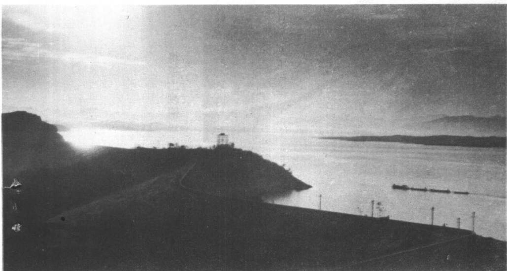
大别山水库群之一——沙壳粘土心墙结构的龙河口水库大坝
