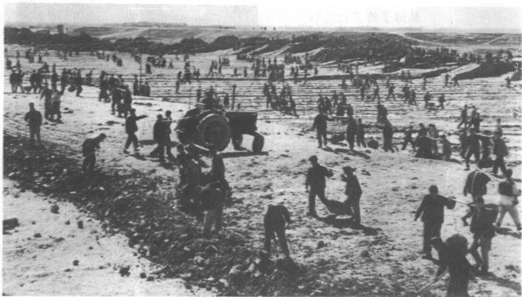
肥西、舒城、庐江三县二十万民工战斗在杭埠河改道工地上。
