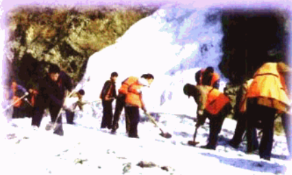
延吉市公路管理段职工及时清除公路上的冰雪，确保春运期间的旅客运输安全
