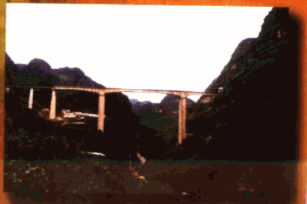
世界第一铁路高桥——南昆铁路清水河大桥
