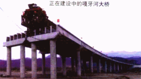
正在建设中的嘎牙河大桥
