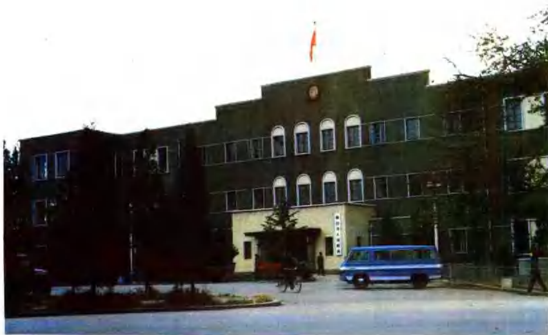
鞍山市人民政府办公楼
