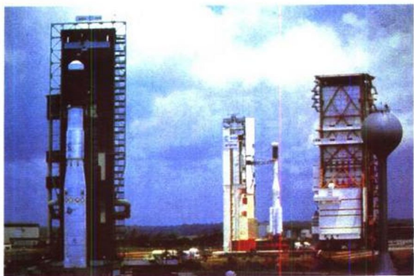
欧洲空间局的库鲁航天中心（局部）
