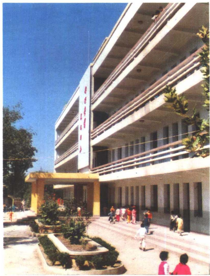
县实验小学教学楼
