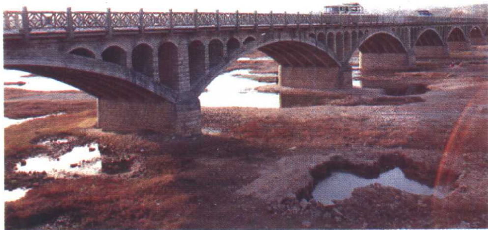
广水东河大桥
