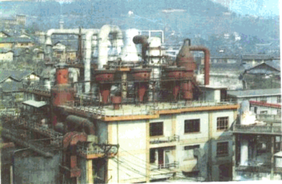
▲乐山盐业集团五通桥三盐厂年 产三万吨的真空制盐装置
