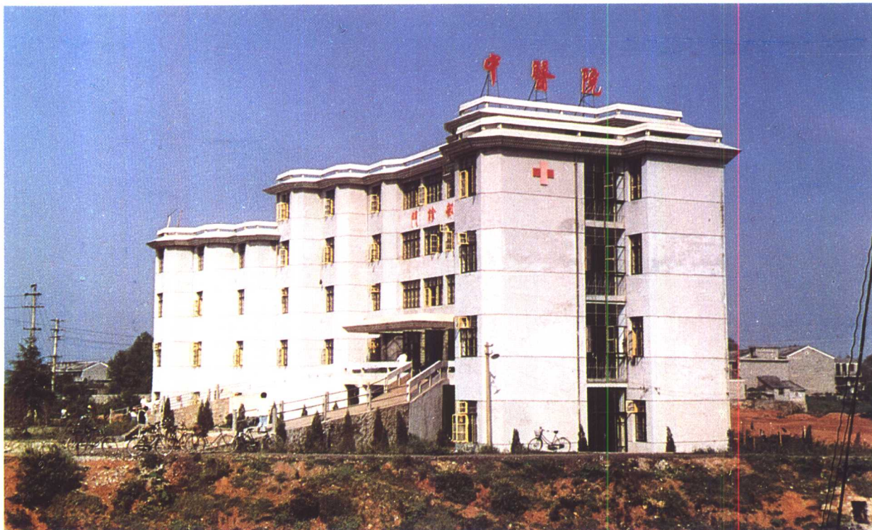
新干县中医院大楼
