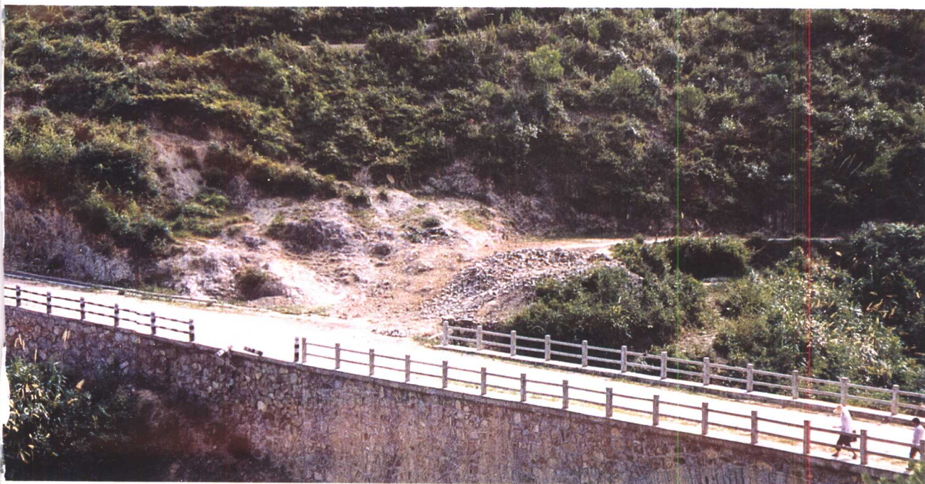
世界银行贷款修建的窑里至蜜蜂街山区公路窑里段
