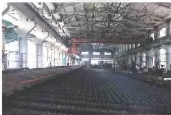
南通海门钢厂轧钢车间
