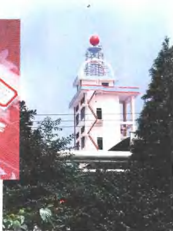
海门化工总厂 7000 吨双氧水车间
