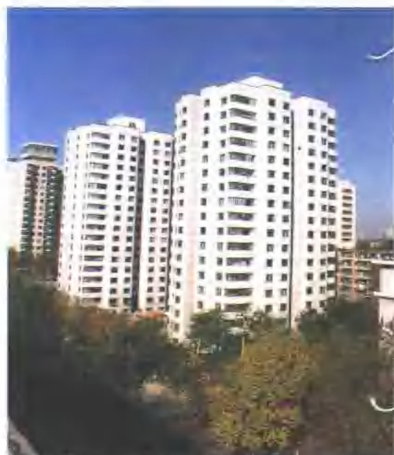
南通三建六分公司承建的国家石油部高层住宅楼
