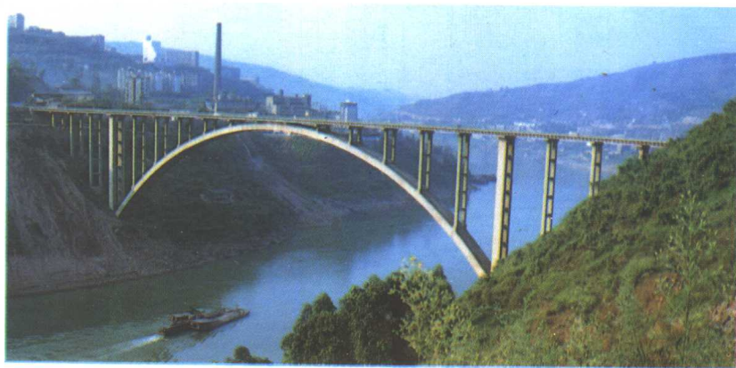
▲连接东西城区的乌江大桥
