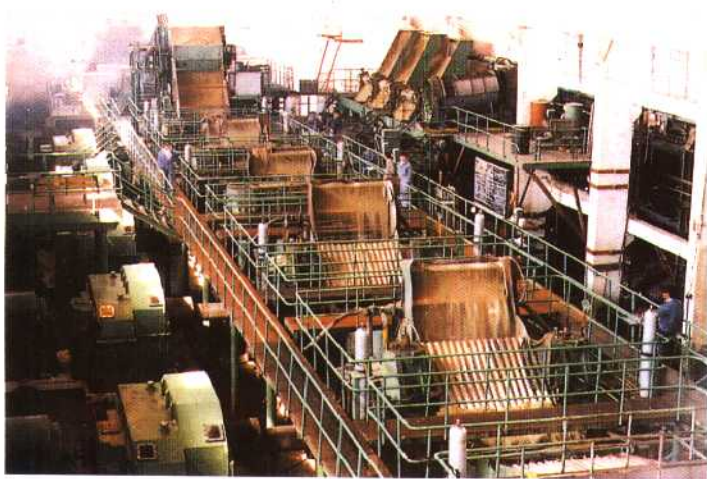
市头甘蔗化工厂生产车间
