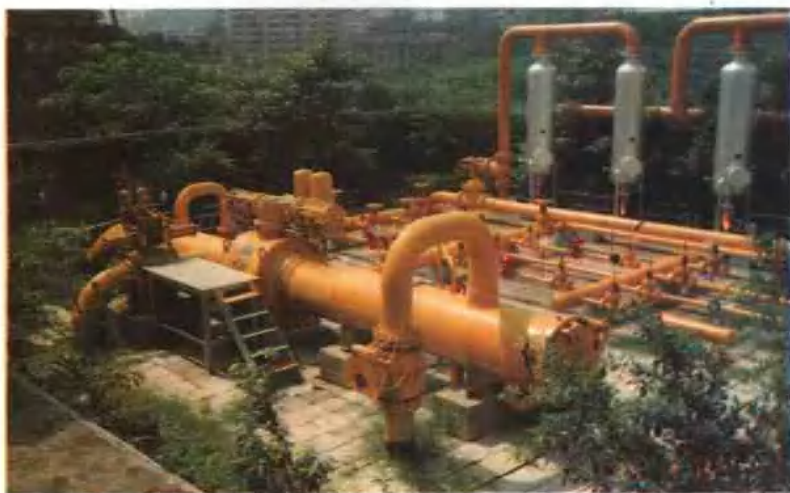
自贡高压阀门总厂生产的动力球阀、气/液联动球阀、闸阀等产品在黄骅穿越长江工程集输站
