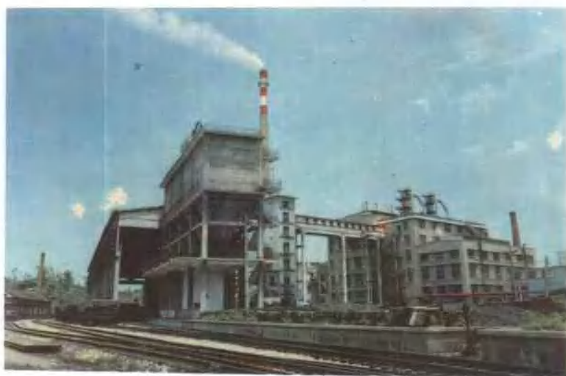
张家坝制盐化工厂 2 \times 3000 千瓦自备电站
