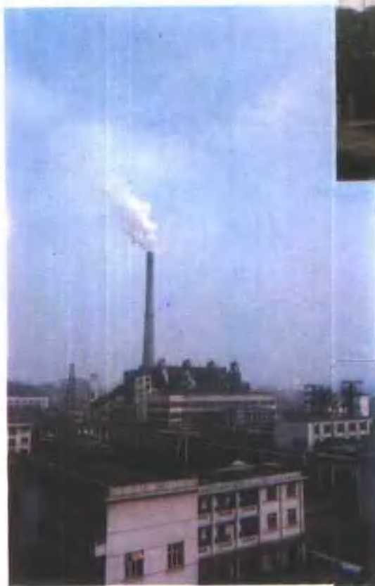
自贡市鸿鹤化工总厂热电站
