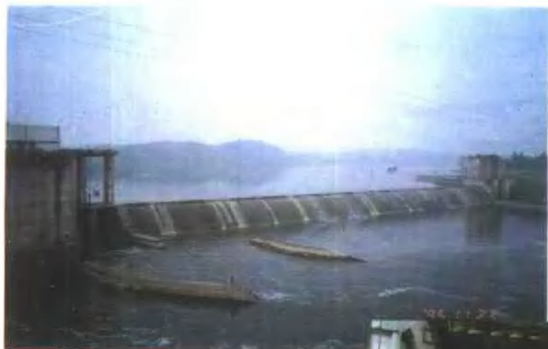
富顺县黄葛滩水电站
