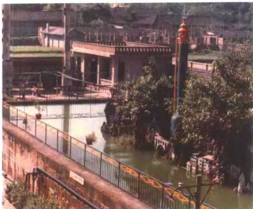
荣县酒厂大型沼气池
