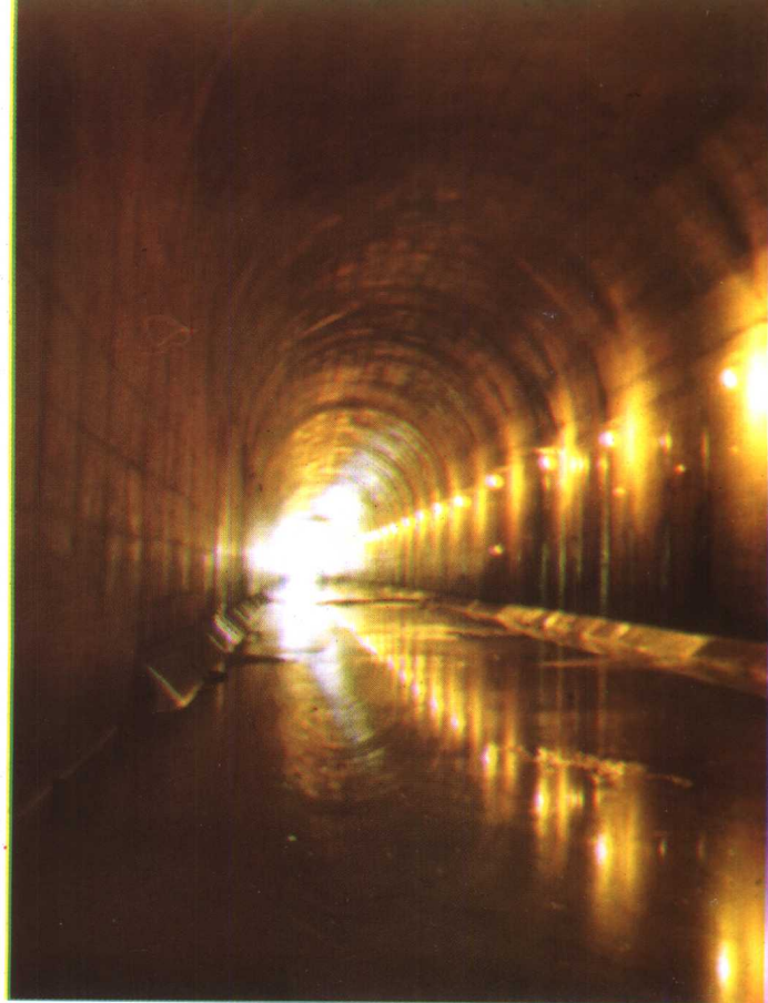
▲ 引滦入津引水隧洞
