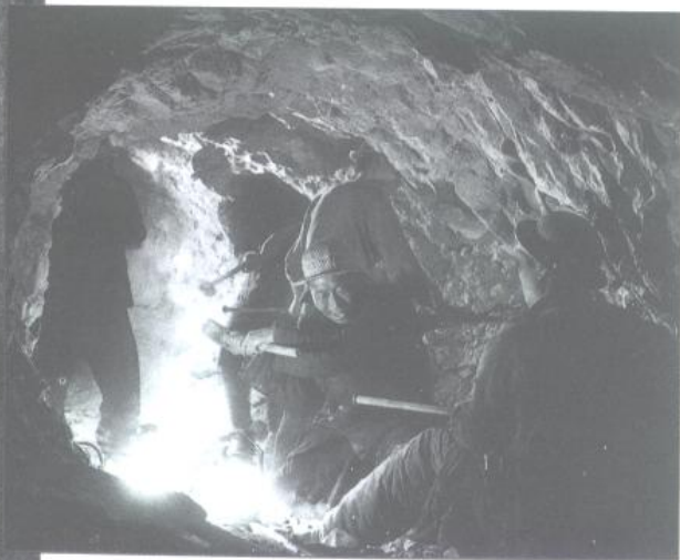
林县副县长、红旗渠工程指挥长马有金同民工一起开凿引水隧洞
