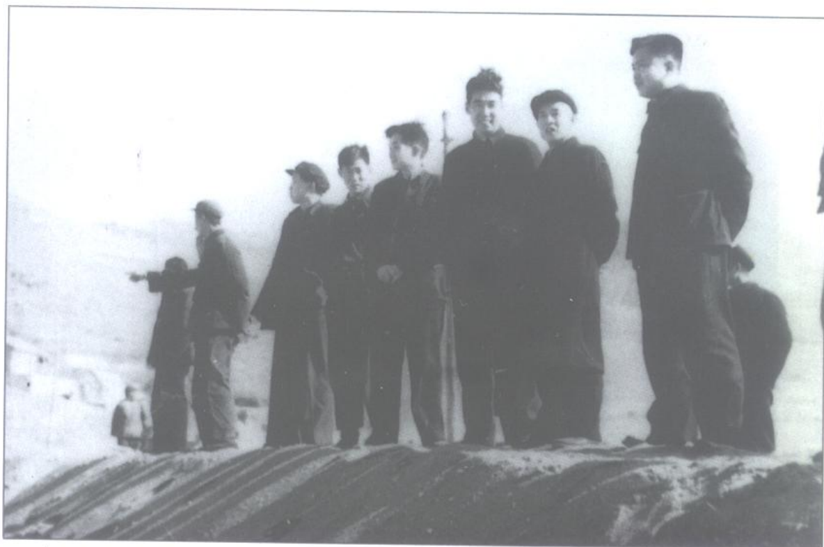
1959年11月6日，共青团中央第一书记胡耀邦来林县参观水利建设工程。
