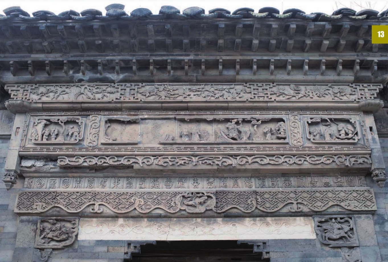
彩图 25 大路镇中兴东路 81 号孙氏民居仪门砖雕门罩竭尽精工之能事：上额枋回纹镶边围绕三组梅花图案，垂花门挂落镂雕卷草，匾额、兜肚镂雕人物，已损；束腰剔地平起 27 个福、禄、寿字，严谨工整；下额枋雕做基座造型，曲线边缘打破常规，别具韵律，海棠形开光内雕仙鹤梅花鹿；垂花柱柱头圆雕花篮最为精彩。工匠功力，令人叹服。
