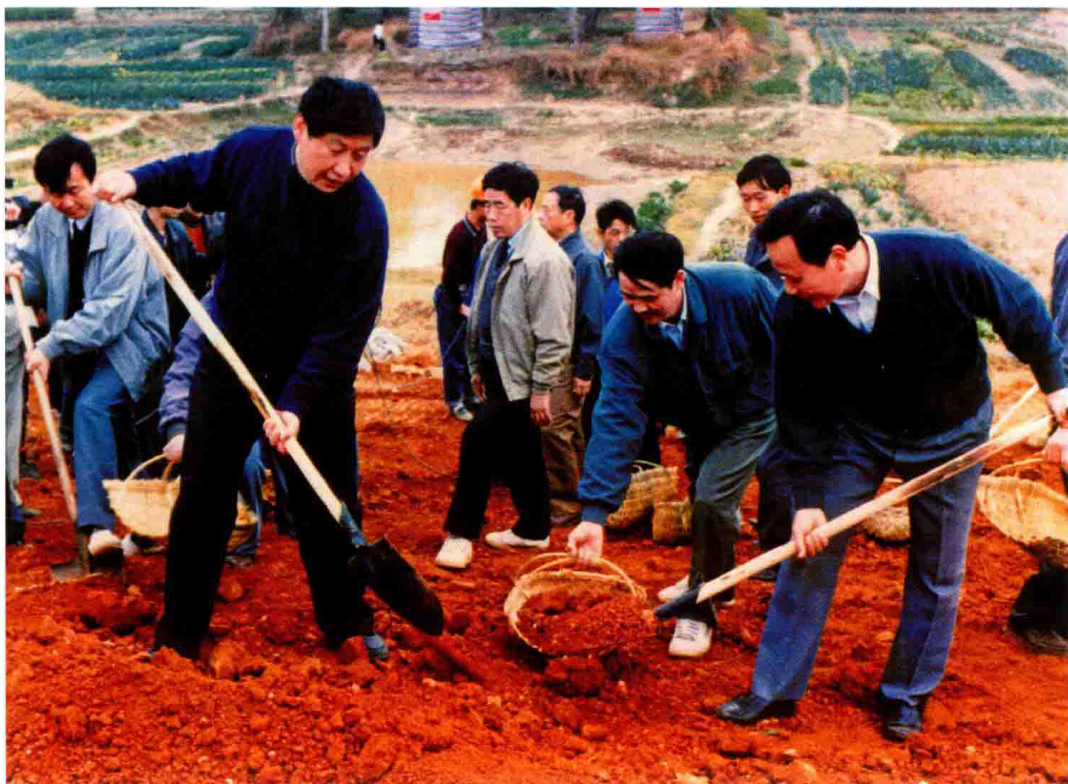
Em dezembro de 1995, Xi Jinping, então subsecretário do Comitê do PCCb na província de Fujian e secretário do Comitê do PCCb no município de Fuzhou, trabalha numa obra de reforço do dique no curso inferior do rio Minjiang, no distrito de Minhou.
