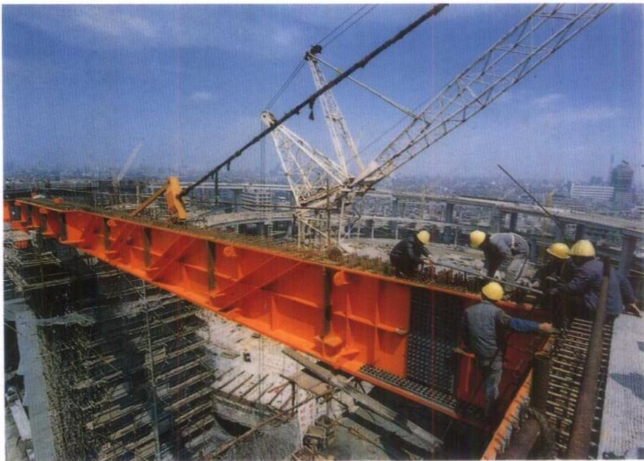
图8-98 南浦大桥钢梁连接
