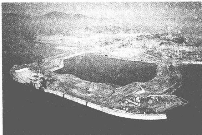
图1-3 三峡围堰工程
