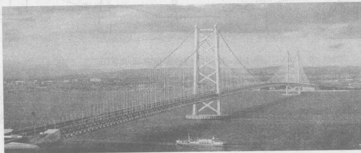
图 1-6 日本明石海峡大桥
